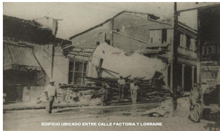
Anexo 2.2. Daños producidos por el terremoto de 1932 entre calle Factoría y Lorraine. Foto Archivo CENAIS.
